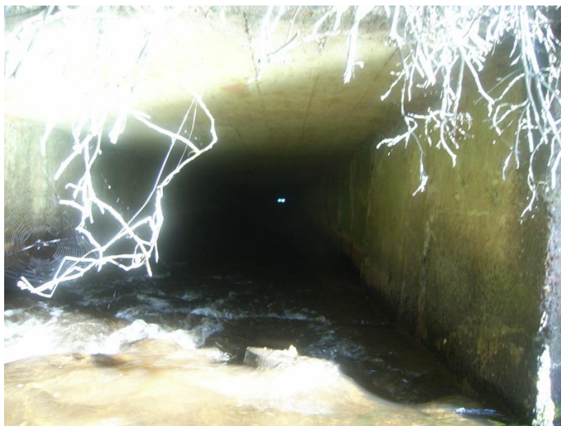
Figur 1.3 Indløb af rørlægning. Rørlægningen er et 78 m langt kasseformet betonprofil, der ligger med jævnt fald. Det er muligt at se fra indløb til udløb.
