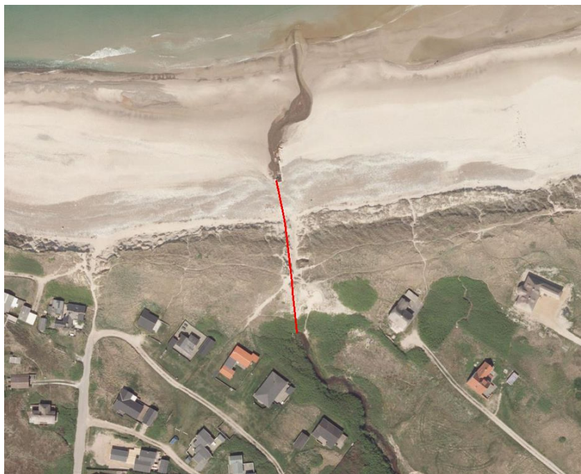
Figur 1.2 Luffoto med rørlægning AAL-1134's beliggenhed gennem klitten inden udløbet i Vesterhavet.
