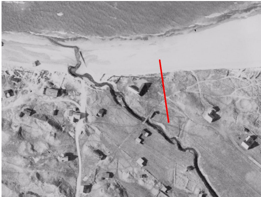
Figur 5.1: Luftfoto fra 1954 visende Klitmøller Å's forløb før rørlægning gennem klitten. Den røde streg er den nuværende rørlednings placering.
